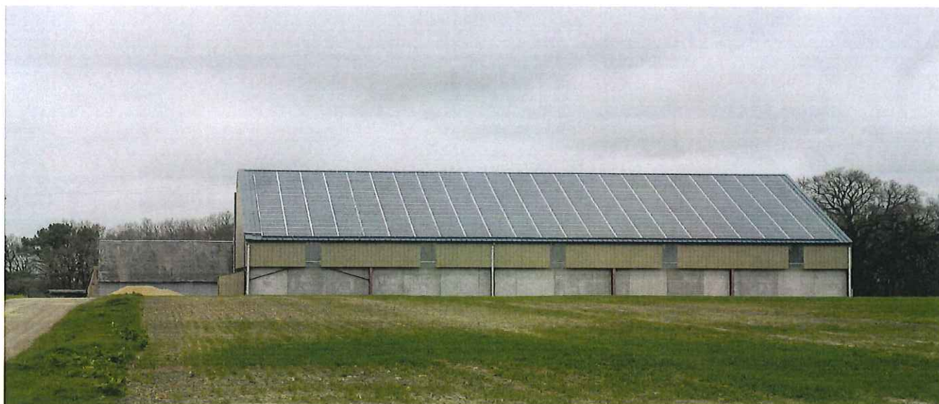
Toiture photovoltaïque – Indre – photo DDT 36 (mars 2020)
